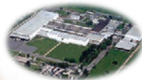
Fábrica de Correias e Tensionadores
